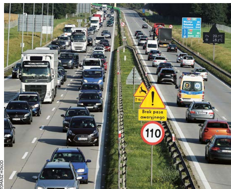
Kamery zamontowano pomiędzy Kostomłotami a Kątami Wrocławskimi
