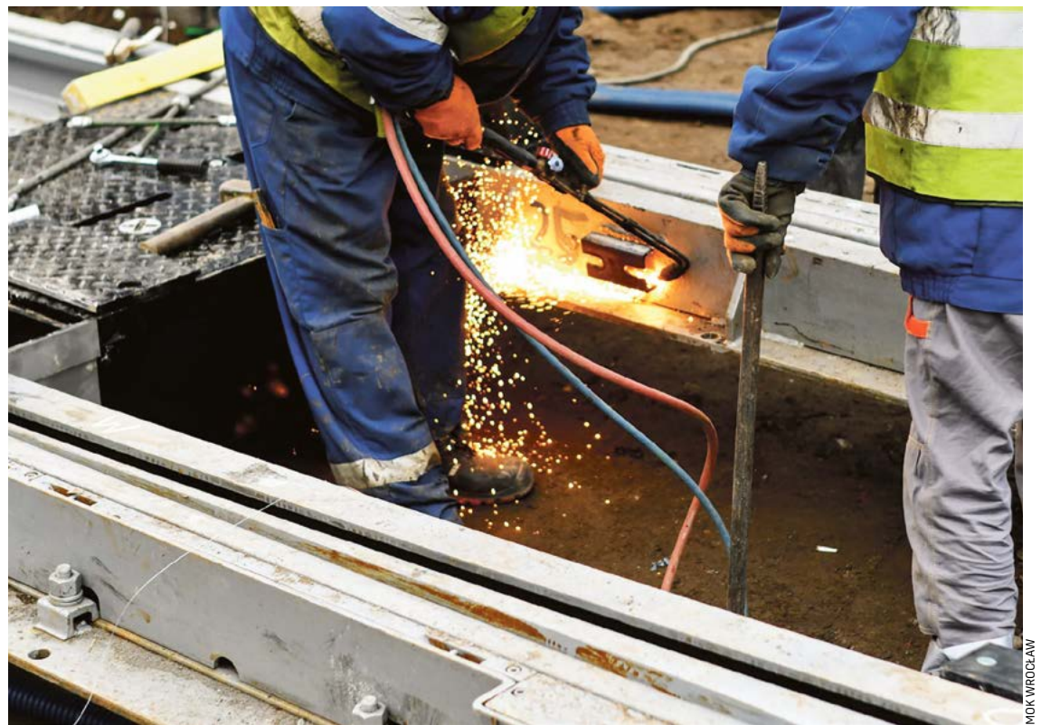
Wymiana rozjazdu i krzyżownicy przy skrzyżowaniu ul. Świdnickiej i Piłsudskiego usprawni komunikację
